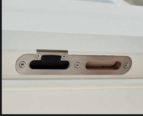
Detail: Magnetschließblech zum Verstellen
