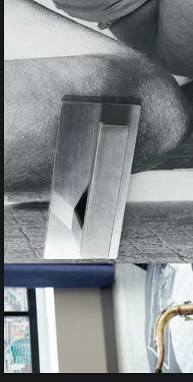
Detail: Schlosskasten Askara von der Bandseite
